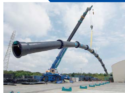
耐震管路(継手構造)の敷設 三重県紀宝町
