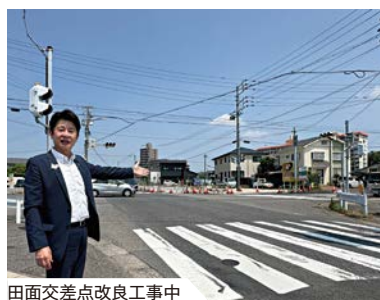
田面交差点改良工事中
