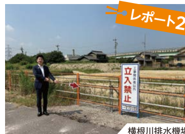
横根川排水機場
